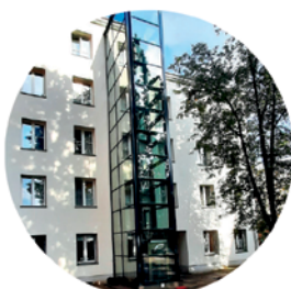
Doposażenie budynków komunalnych w windy zewnętrzne
