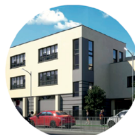
Budowa kompleksu sportowego na Gołędzinowie i budowa hali sportowej przy Szkole Podstawowej nr 73 przy ul. Białostockiej
